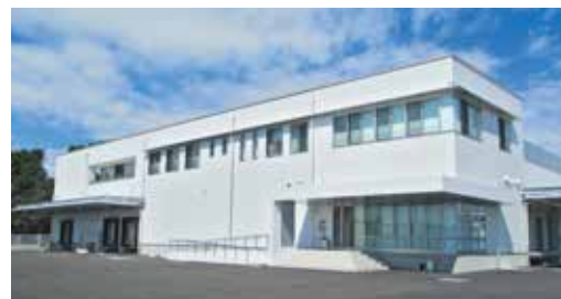
【加西市南部学校給食センター】 構造:鉄骨造2階建 敷地面積:44,528㎡ 調理能力:最大2,000食/日
